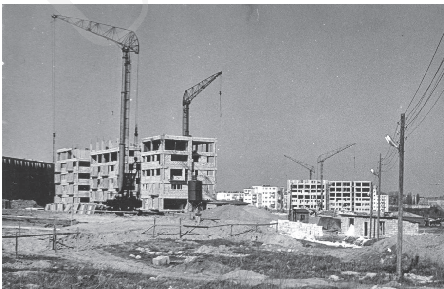
Fot. 3. LSM, budowa os. Słowackiego – widok na bloki na ul. Wileńskiej, bez daty; fot. ze zbiorów Teresy Gralewskiej, własność Fundacji Lubelska Agora Modernizmu.
