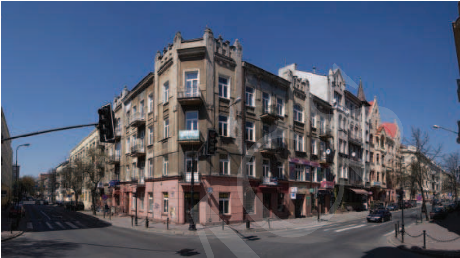
Ilustracja 11. Kamienica przy ul. Chopina 15. Fot. P. Maciuk 2010.
