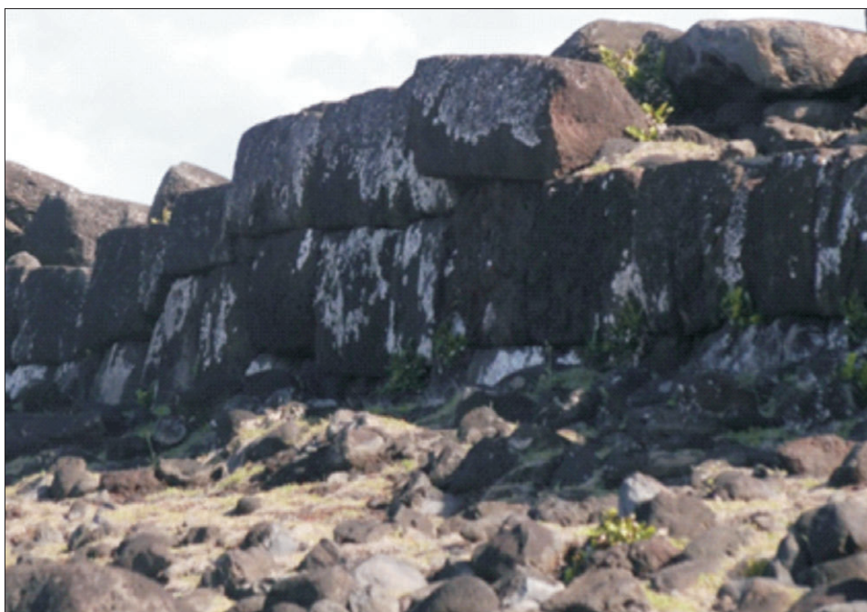
Ryc. 4. Sól oceaniczna wytrącająca się na powierzchni skał tworzących obudowę zewnętrzną Ahu Vaihu (fot. M. Telecka)
